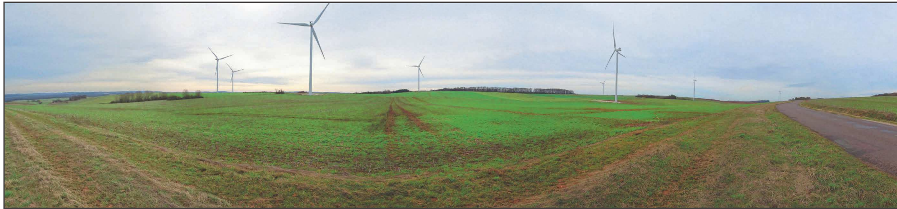
Photo 32 : Le parc éolien de Haut-Chemin sur le plateau très ouvert, entre Ageville et Biesles. (© agence Coûasnon)
